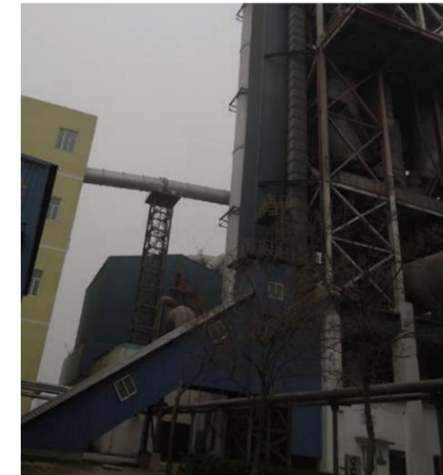
图9 物料通过提升机入窑方式
